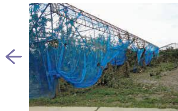
令和2年7月28日 記録的豪雨・最上川氾濫後
